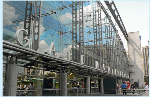
Fassade des Gare Montparnasse
